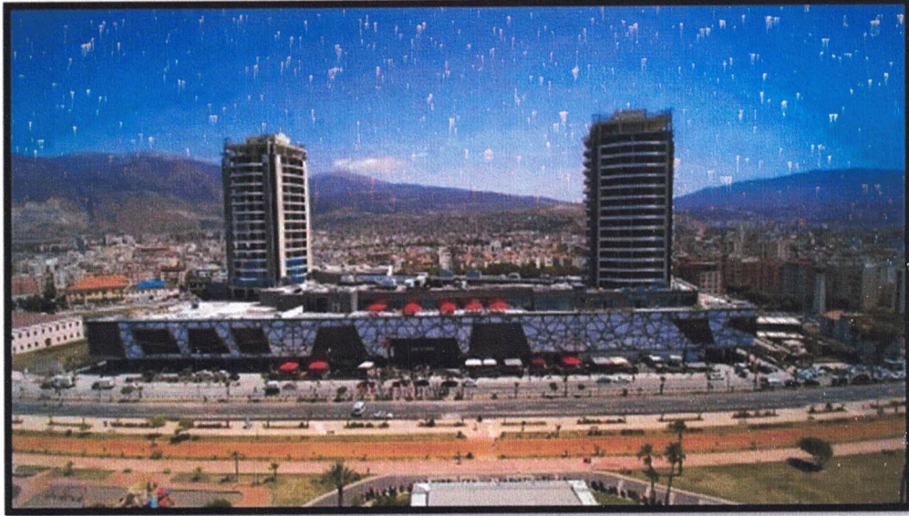
Süleymaniye Mahallesi Park Forbes Turizm Kompleksi
