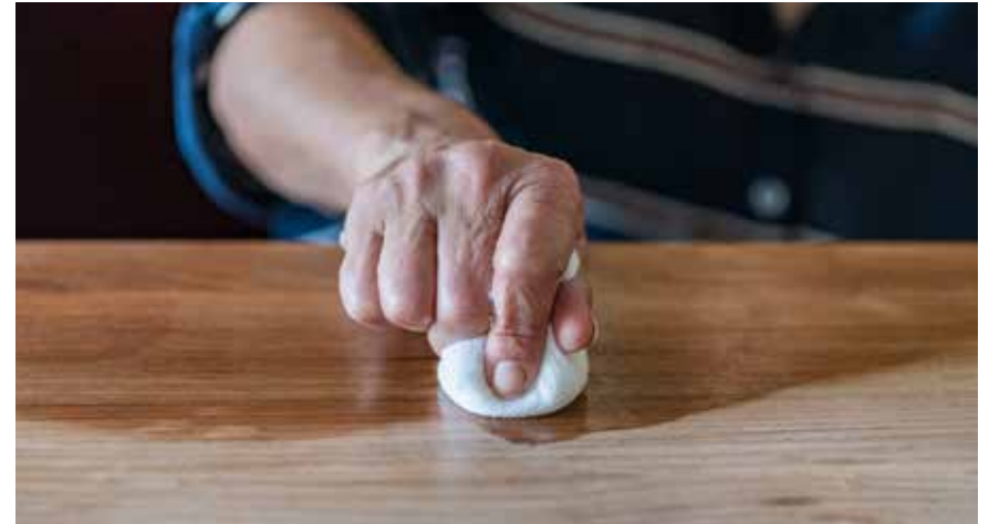
Resim 14: Pürüzsüz zemin pamuk ve yağ kullanılmak suretiyle yağlanır ve ağaç, gomalak cilasına hazır hale getirilir.
